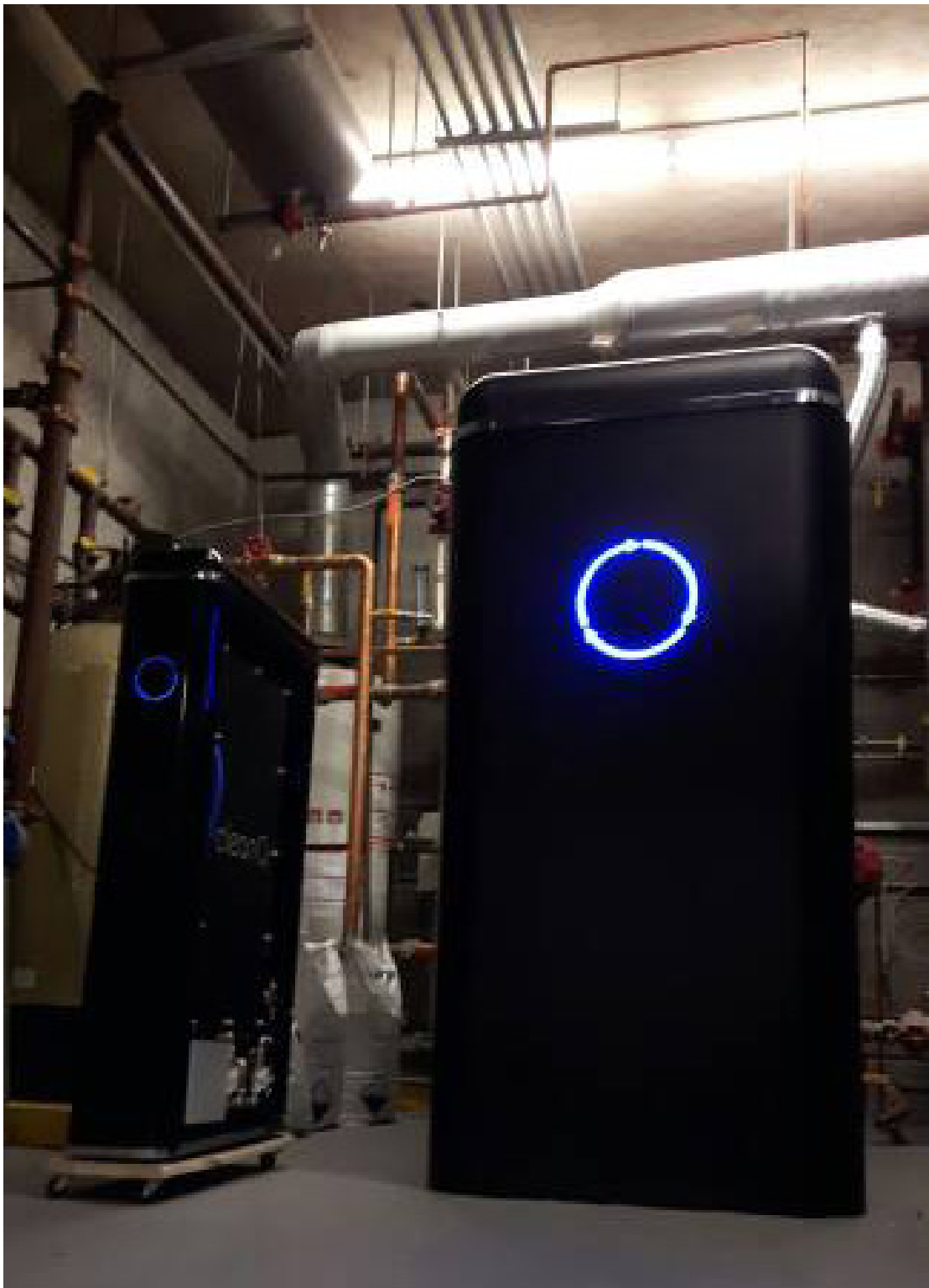
“The CleanO2 unit, called ‘CARBINX’, is about the size of a residential air conditioner.” Image courtesy of CleanO2 Carbon Capture Technologies Inc. | « L’unité CleanO2, appelée « CARBINX », est environ de la taille d’un climatiseur résidentiel » Photo de la part de CleanO2 Carbon Capture Technologies Inc.
